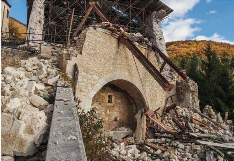
მიწისძვრის მიერ დაზიანებული არაკარკასული სტრუქტურა, იტალია, 2017. ფოტო: ეისუკე ნიშიკავა
