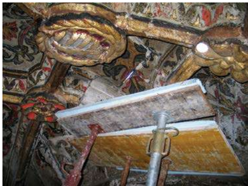
დამკავი-საიზოლაციო ფენა მოხატულ კედელსა და ბიჯს შორის, ფრეიშუდი-ეშპადას ეკლესიაში, პორტუგალია, 2007, ფოტო: ესპერალდა პაუპერიო
