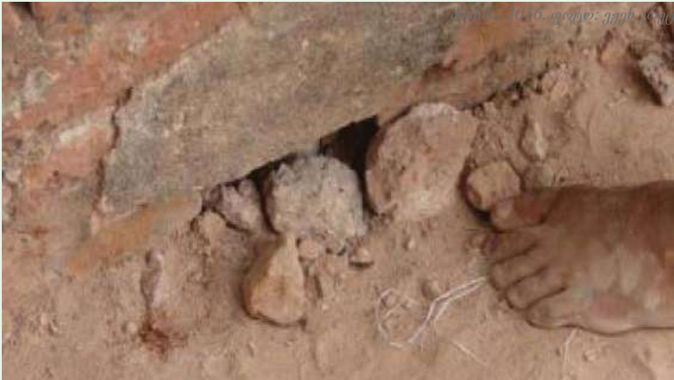
ხვრელები პავლას სახურავის წყალგამძლე სისტემაში ბავანში, მიანმა, 2016, ფოტო: ევენ კრეტ
