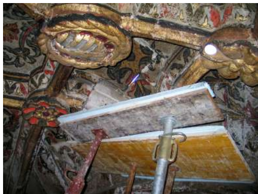
لایه محافظ و جدا کننده میان نقاشی دیواری و پایه خوازه در کلیسای فریکسو دی ایسپهده سینتا، پرتغال، ۲۰۰۷. تصویر: ایسمیرالدا پوپپرو
