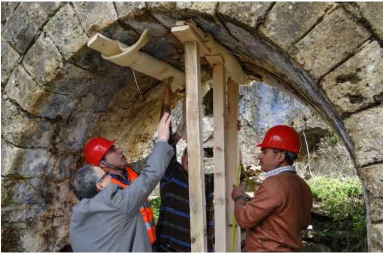
تثبیت اضطراری حالت در عمل، در کارگاهی در شوف، لبنان، ۲۰۱۴. تصویر: موسسه اکرام-اتار
