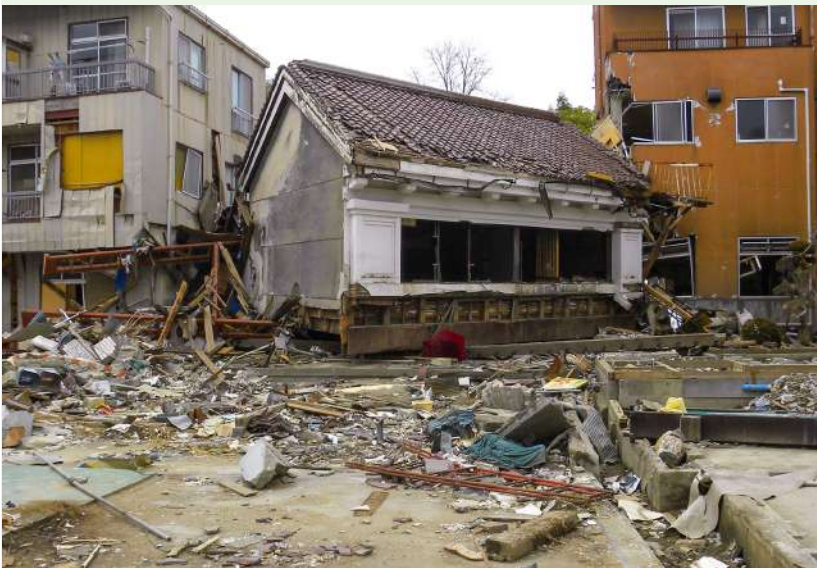
東日本大震災の津波によって破壊された建物。2011年。 写真：宮城県。
