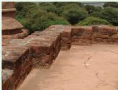
ある寺院で発生した屋根のひび割れ(バガン、ミャンマー)。2016年。 写真: ユージニー・グレーテ。
