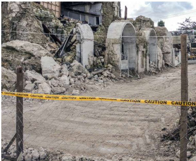
大きな被害を受けたフィリピンの教会で、安全確保のために設置された、立ち入り禁止地域と立ち入り禁止の規制線。2013年。写真:アバーナ・タンドン ICCROM)。
