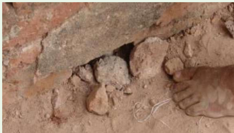
屋根の排水口にできた穴。(バガン、ミャンマー)。2016年。 写真: ユージニー・グレーテ。
