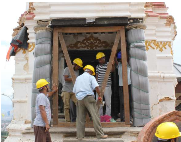
ネパール、カトマンズで発生した緊急事態での、寺院の安定化。2015年。写真:ICCRROM
