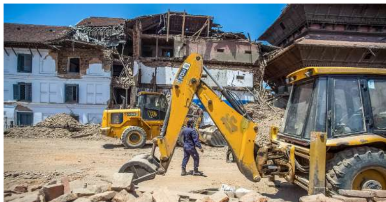
ネパールのカトマンズで発生した地震で行われた瓦礫等の撤去作業
