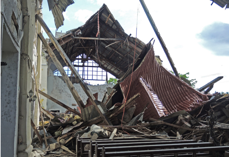
Depremde hasar görmüş bir kilise, Bohol, Filipinler, 2013. Foto: Aparna Tandon, ICCROM.
