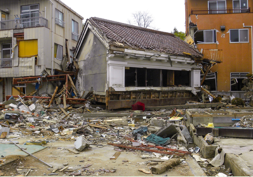
Japonya'nın doğusunda tsunami nedeniyle çöken bir bina, 2011. Foto: Miyagi Kaymakamlık Heyeti.
