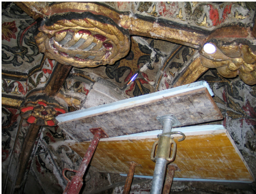
Tavar resmi ve payanda arasındaki koruyucu ve izolasyon sağlayıcı katman: Freixo de Espada à Cinta Kilisesi, Portekiz, 2007. Foto: Esmeralda Paupério.
