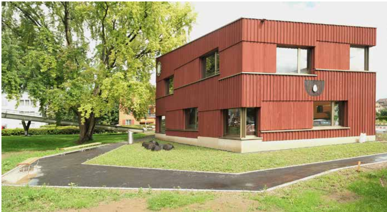
Der neue Doppelkindergarten Gjuch.
